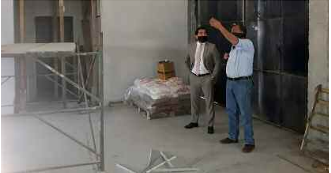
David Tonello junto al funcionario municipal Camilio Vieyra durante un recorrido por las obras del quincho.
