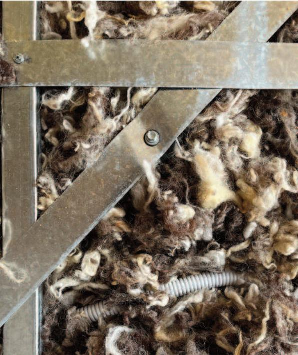
Aplicación en Steel Frame Biocool formato lana suela, ideal para bajar libre acceso a instalación eléctrica
